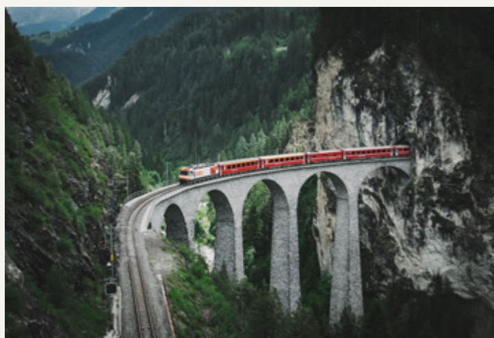
Landwasserviadukt © Bergün Filisur Tourismus
