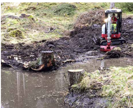
Arbeiten für den neuen Teich im Rösenwald, Filisur
