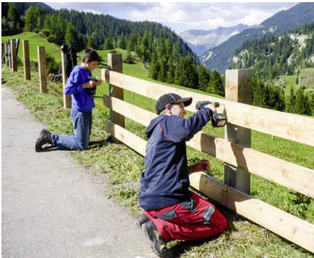
Neue Holzzäune wurden u.a. in Bergün aufgestellt.
