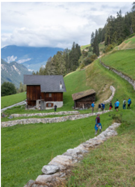
Sanierte Trockenmauern in Buorchas bei Bergün
